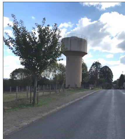
Réservoir du bourg - Source : Gt 2018
